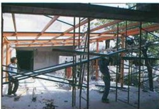
La unitat anterior en construcció, quan es bastia el passadís que uneix els dos antics pavellons.
