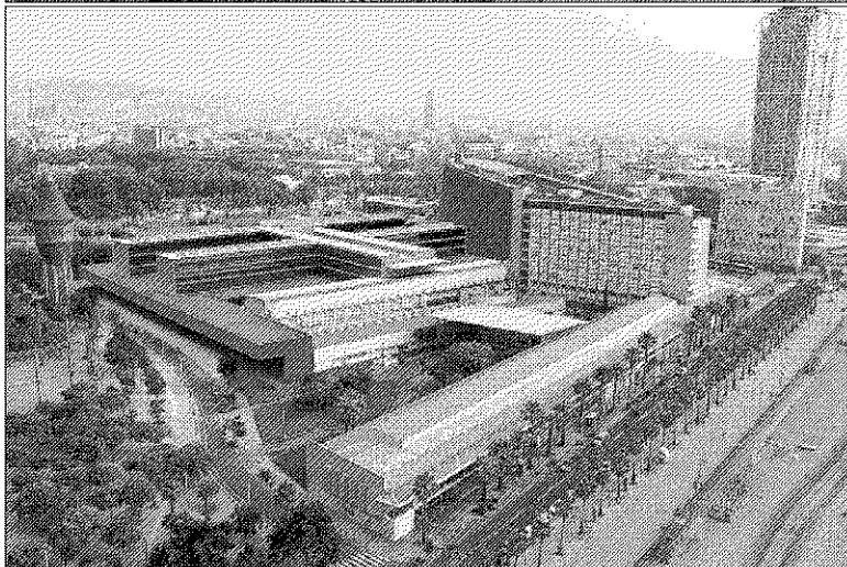
LA ACTUAL ESTRUCTURA del Hospital del Mar (fotografía de arriba), con 12 pabellones perpendiculares a un pasillo central, cambiará. Se mantendrá el pasillo, más amplio, pero en lugar de 12 pabellones se construirán cuatro (dos a cada lado), de cinco plantas, como ilustra la simulación de abajo. En el extremo izquierdo se alzará el nuevo edificio de urgencias.
